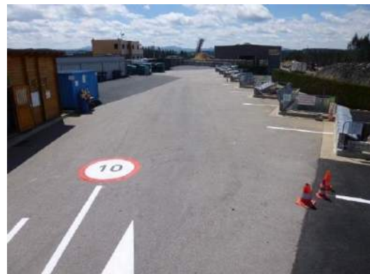
Vue d'ensemble de la déchetterie de Monistrol sur Loire
